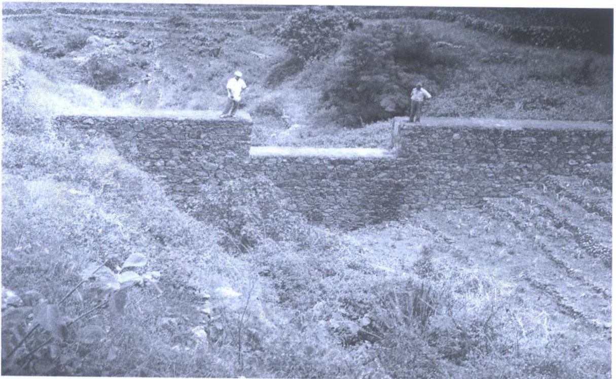
Diques de retenção de sedimentos
