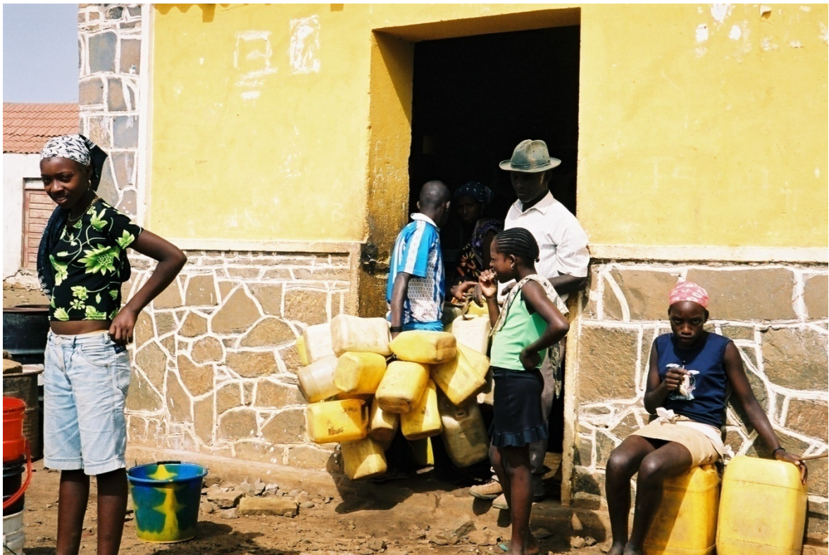
Fig. 3.17. Fontanário para abastecimento de água à população de Ribeirão Chiqueiro e que explora o furo FBE-53.
