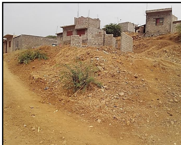
Figura 32 : ocupação nas encostas
