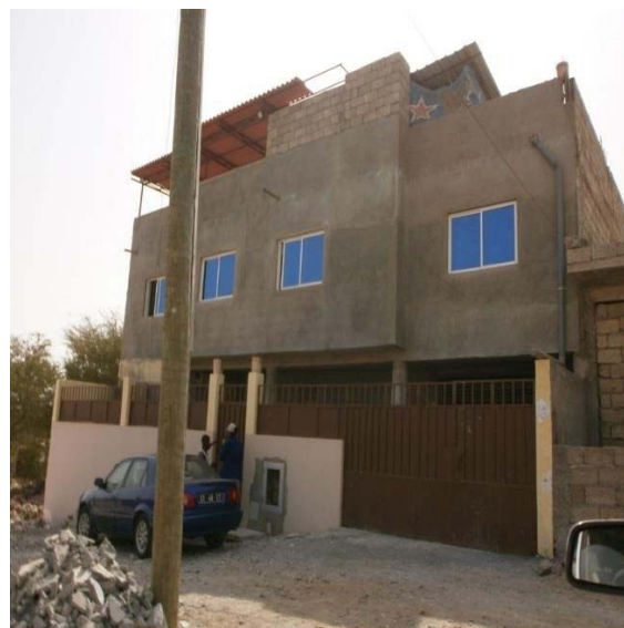
Figura 19 habitação com dois pisos
