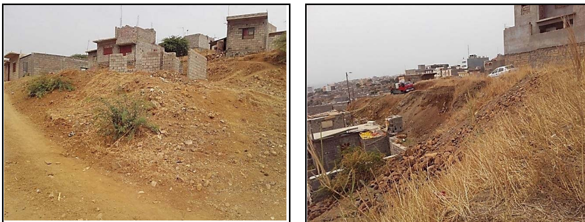
Figura 42: Ocupação nas encostas
