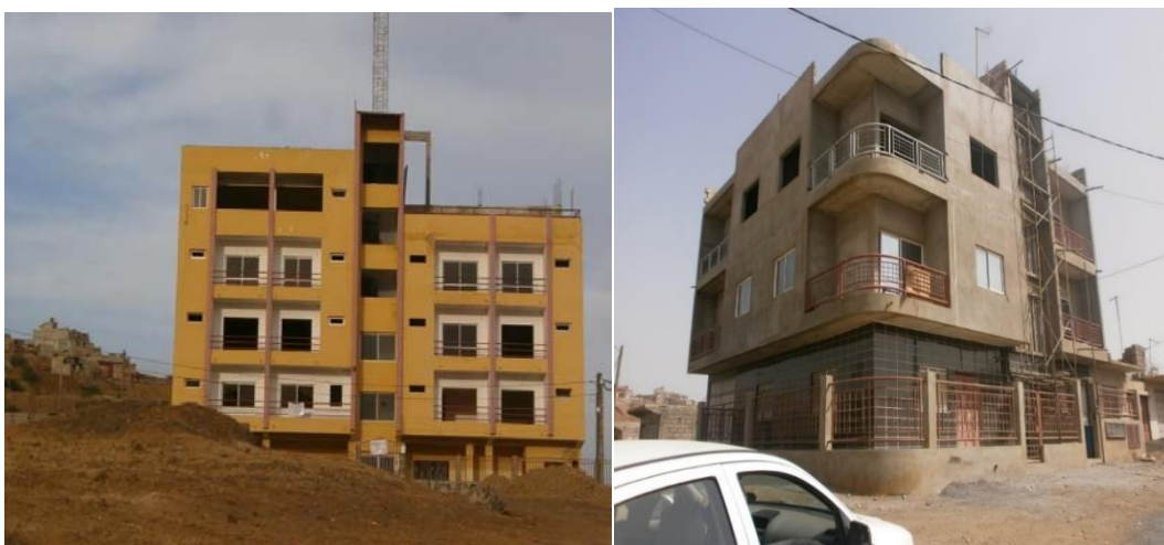
Figura 17 : Tipos de Edifícios
