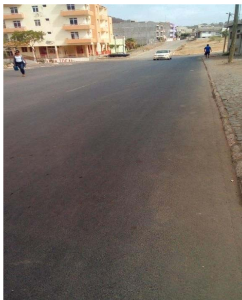
Figura 13 : estrada asfaltada ao longo do bairro TB
