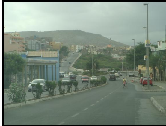
Figura 57 Vista parcial Ligação Rotunda homem de Pedra à Rotunda Terra Branca
