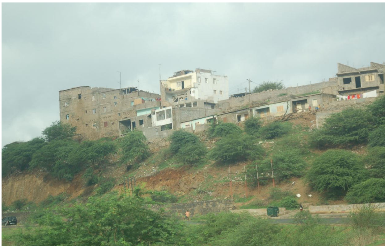
Photo 7 – Habitat précaire sur le versant de Achada Grande Photo de l’auteur
