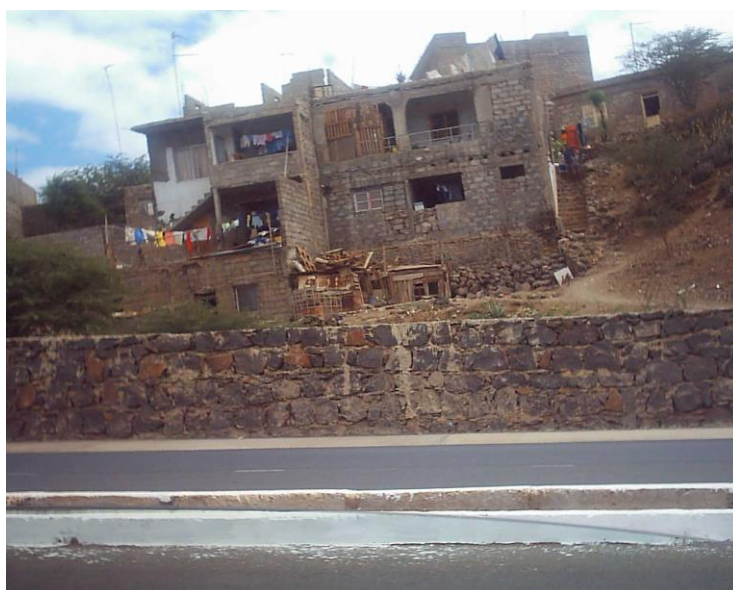
Photo 12 – Aspect d’une maison précaire sur une versante Photo de l’auteur
