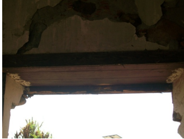
Figura 42 - O forro no lintel da janela, em madeira nobre.
