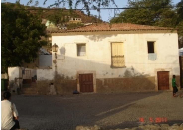
Figura 52 - Sobrado preservado e habitado – fachada principal.
