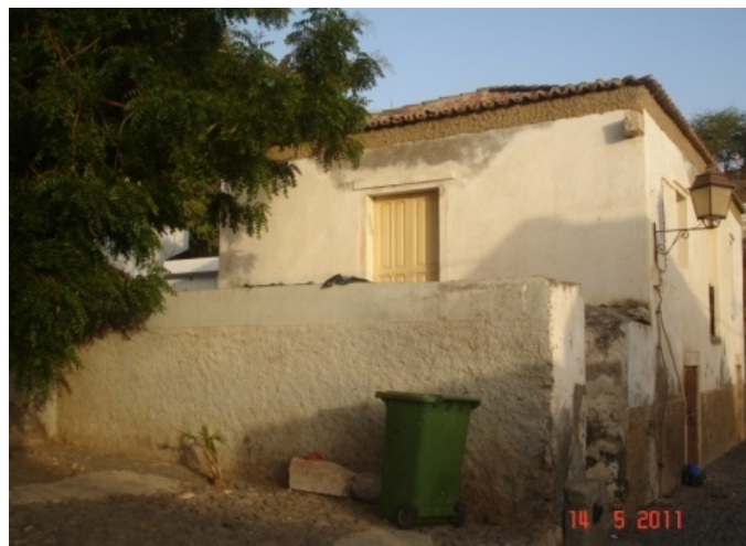
Figura 53 - Sobrado preservado – fachada lateral esquerda e quintal.
