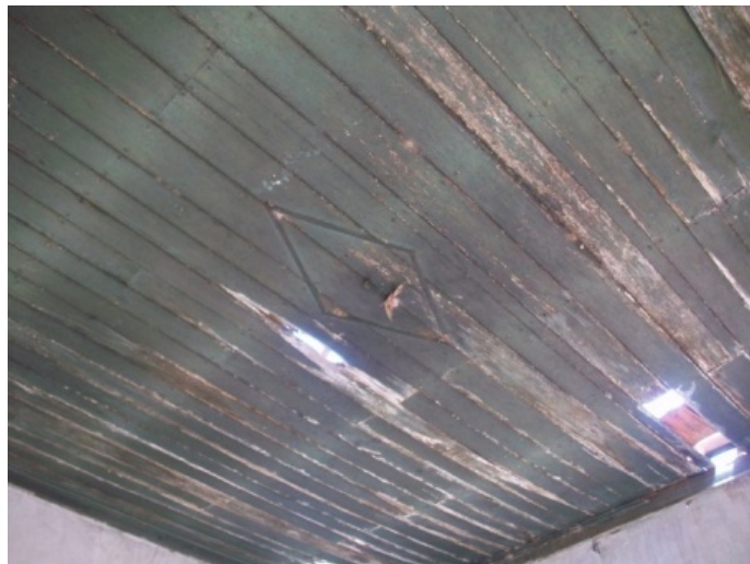
Figura 43 - O forro do teto em madeira nobre e a moldura do centro.
