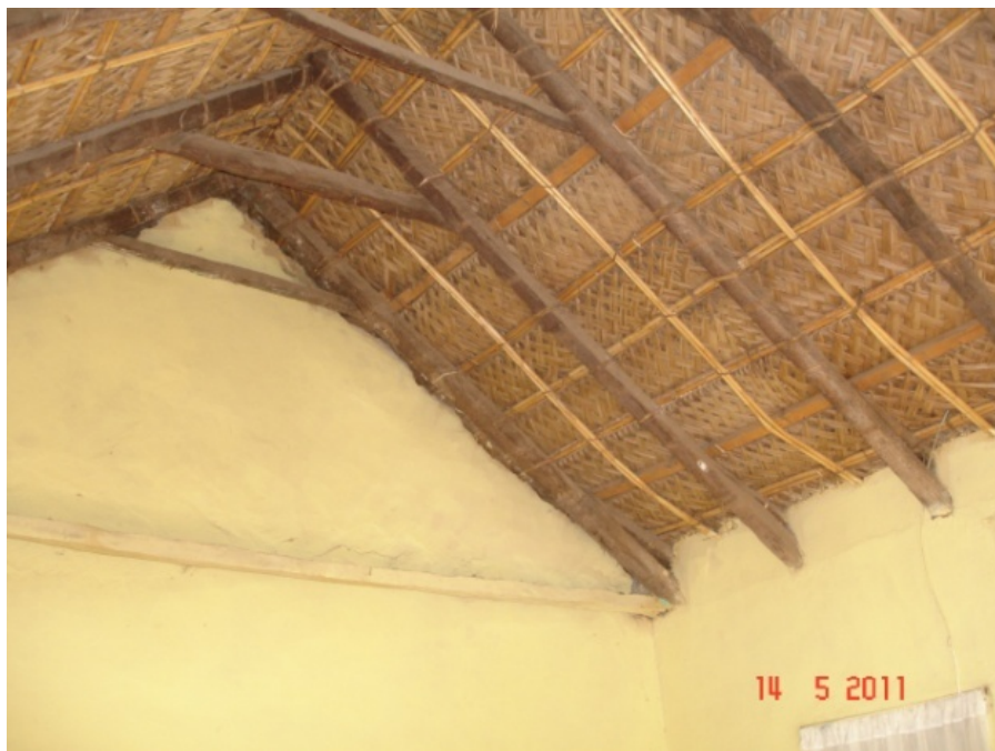
Figura 28 - Interior da casa. Teto de palha sob forro de folha de palmeira entrelaçado.
