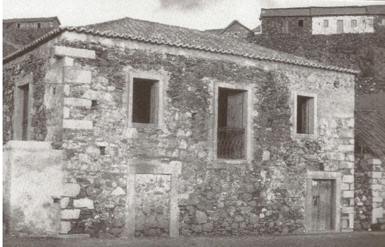
Figura 51 - O mesmo Sobrado, também degradado, nos anos 60.
