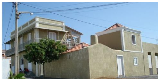
Figura 61 - Sobrado de Nha Martina, recuperado e em bom estado de conservação.
