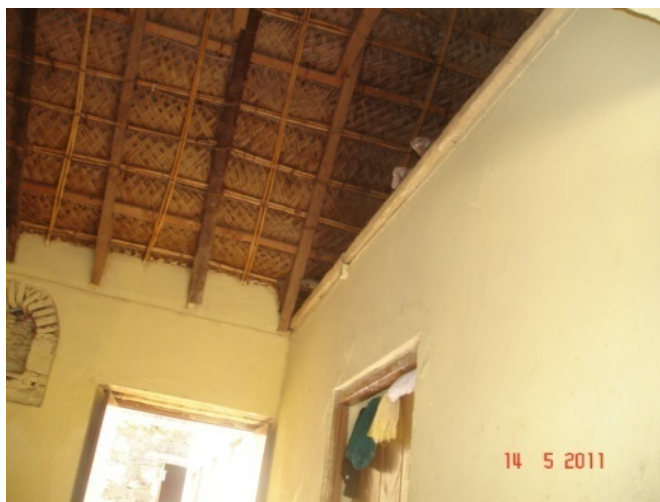
Figura 29 - Divisória do compartimento lateral que serve de quarto de dormir.
