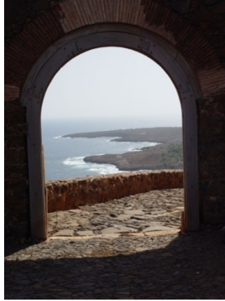
Figura 6 - Imagem da Porta Principal de entrada da Cidade depois de recuperada.
