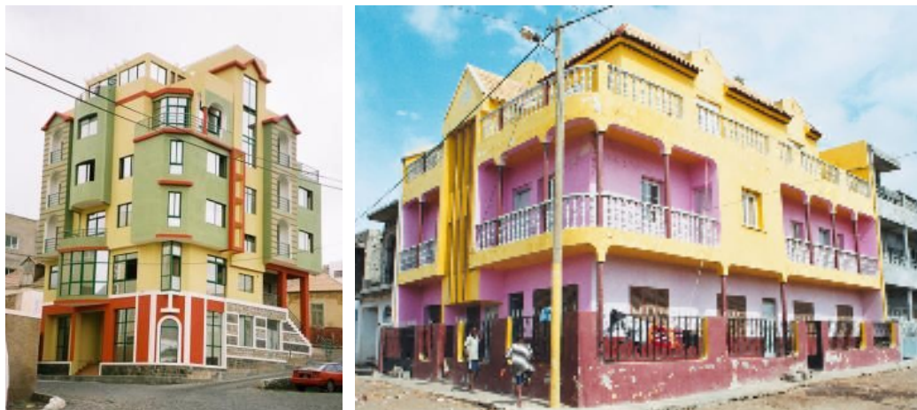
Figura 41 – Construções frequentes em Cabo Verde com inestéticas combinações de cores
