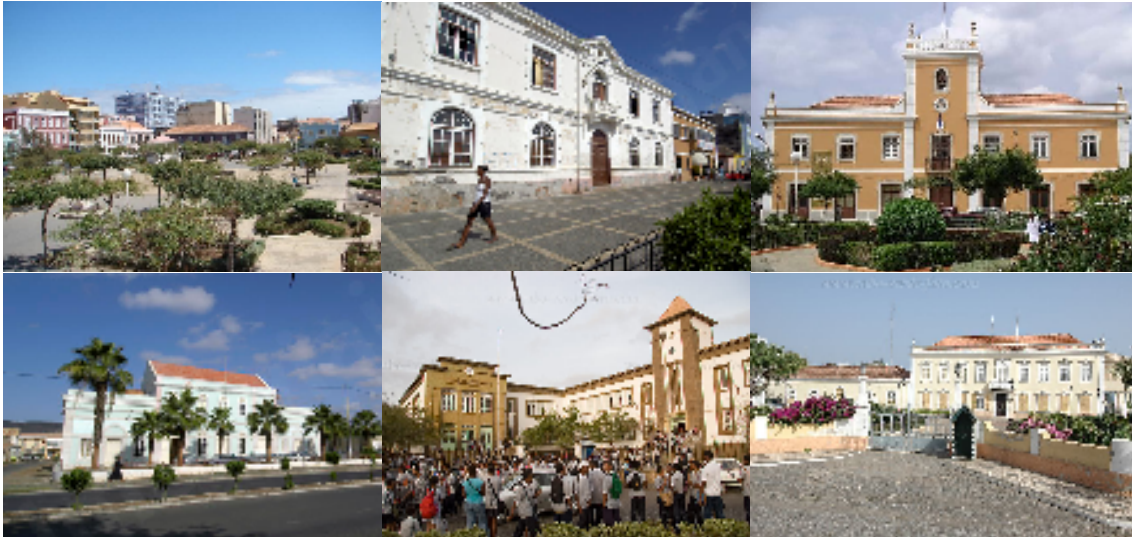
Figura 25 – Vistas de construções antigas (ex-Praça Sá da Bandeira; ex-Escola Principal da Província; ex-Alfândega da Praia; ex-Liceu Adriano Moreira; ex-Palácio dos Governadores-gerais da Província)
