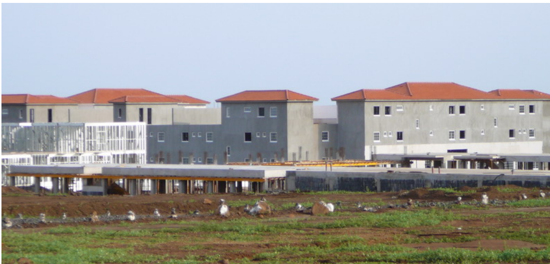
Figura 64 – Primeira fase do projecto de construção da aldeia turística Sambala Village,
