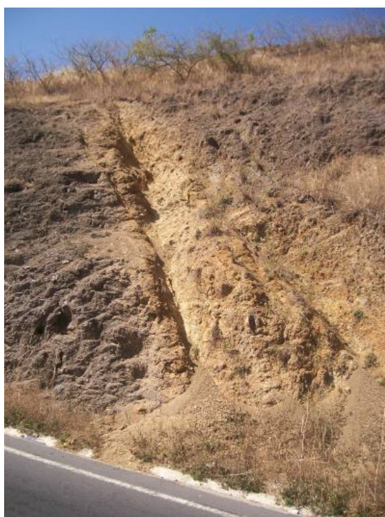
Figura 52. Deslizamento de terras na zona de Godim. Fonte: Autora, 2008
