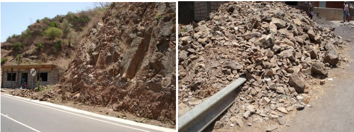
Figuras 29 e 30. Obstrução da estrada por atividades de construção na zona dos Picos. Fonte: Autora, 2009.
