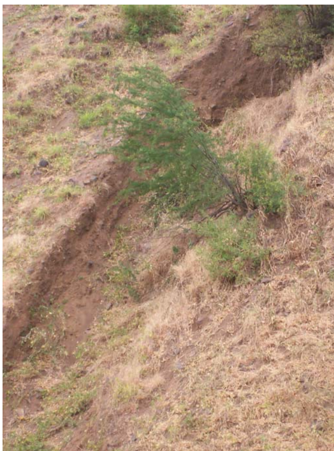
Figuras 87. Erosão por voçorocas no final do trecho 2. Fonte: Autora, 2009
