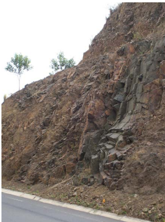
Figura 72. Queda de blocos em basalto na zona de São Lourenço dos Órgãos. Fonte: Autora, 2009
