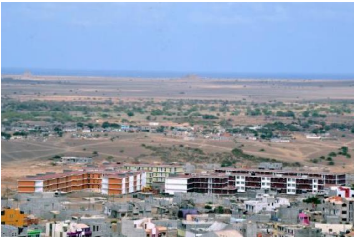
Figura 9: Fotografia da cidade de Espargos, onde se vê os prédios em construção no âmbito do projeto “casa para todos” e mais ao fundo o bairro de Alto de Santa Cruz.
