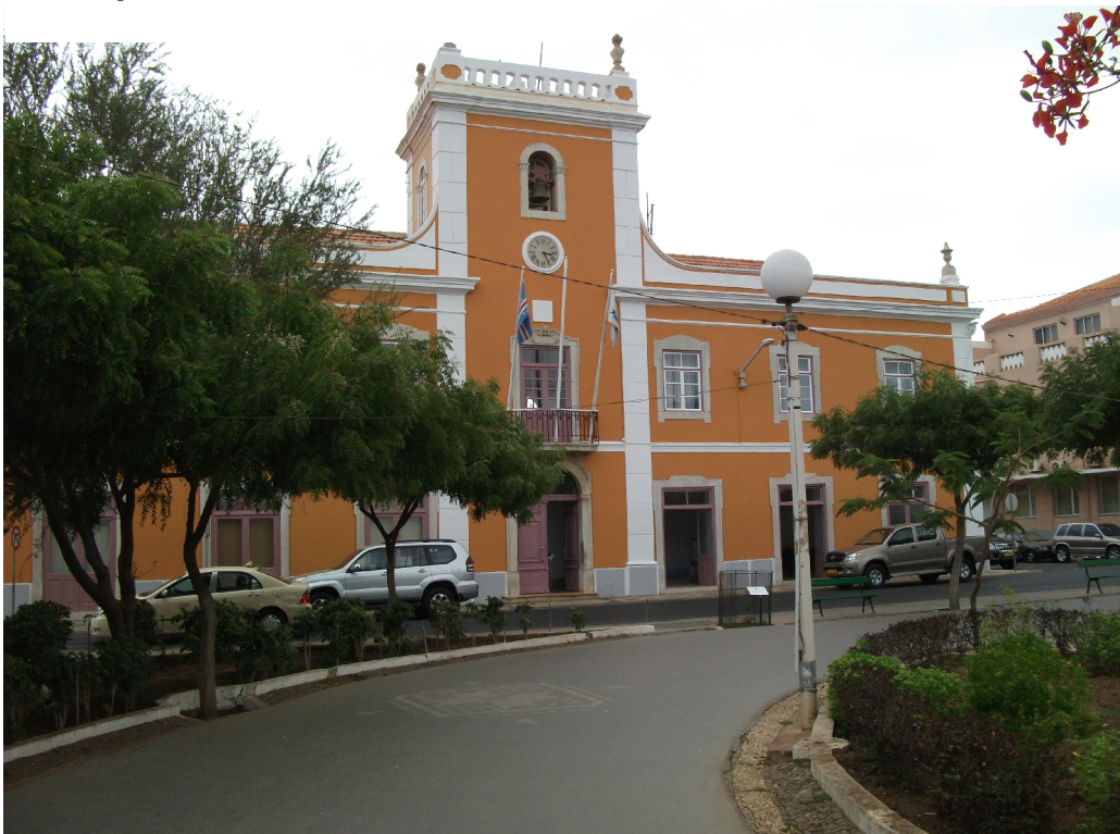
Fig. 2 Edifício da Câmara Municipal da Praia Foto Pesquisador: Julho/2010
