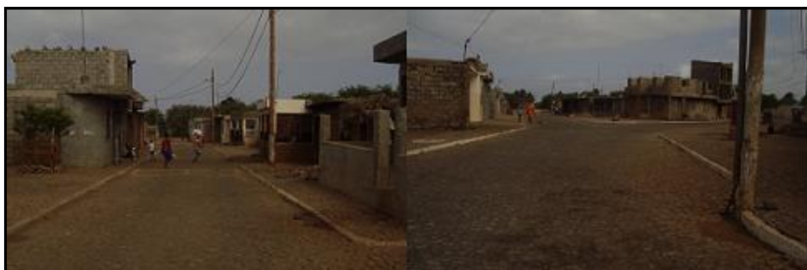
Figura 40 – Aspectos das vias no bairro de Ponta Ribeira – Chão Bom
