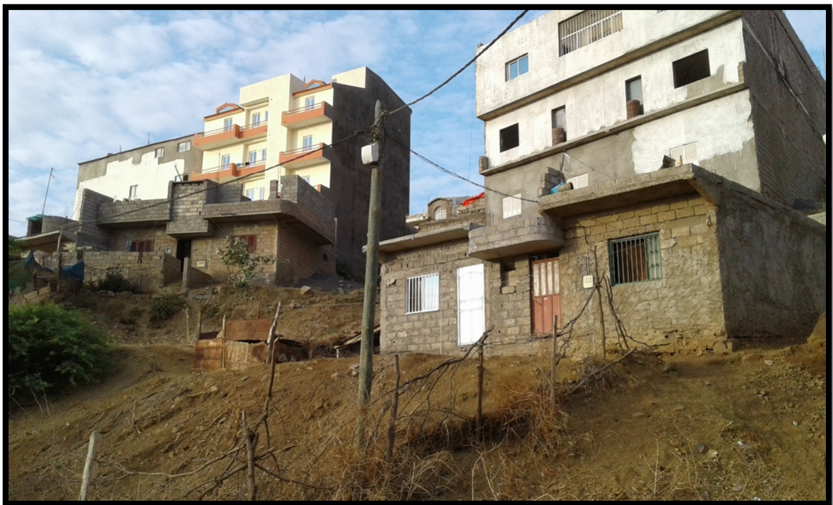
Figura 23: casas inacabadas ou mal construídas encostadas com edifícios de dois ou mais pisos.
