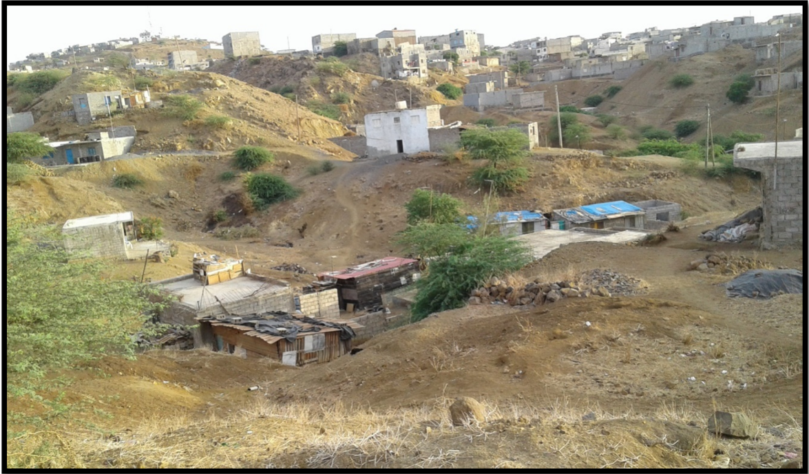
Figura 19: Casas construídas no leito da ribeira com elevada vulnerabilidade a movimentos de vertentes.
