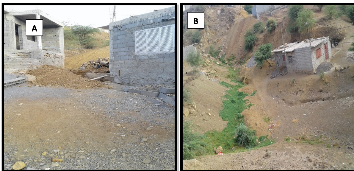
Figura 25: acumulações de terras provenientes das escavações (A, B).
