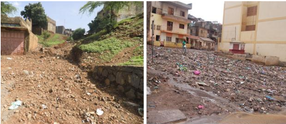
Figuras 21 e 22 - Presença de fluxos de detritos nas encostas de Castelão e Vila Nova (a direita), 2013
