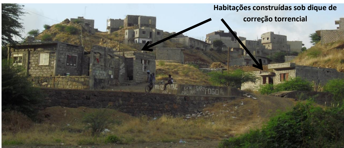
Figura 17 – Habitação construída dentro de dique de correção torrencial (Madjana)
