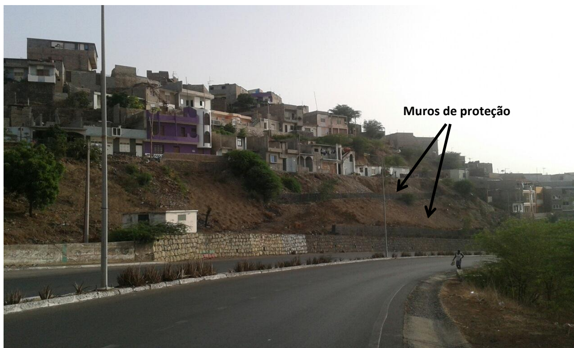
Figura 34 – Muros de proteção/contenção na encosta de Lém ferreira, 2016
