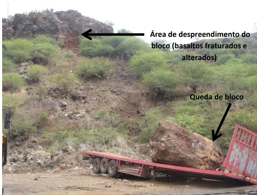
Figuras 24 - Queda de bloco na encosta de Achada Grande Frente, 2012
