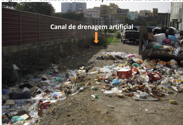
Figura 18 – Resíduos sólidos depositados em canal de drenagem artificial (Várzea)
