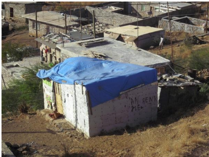
Figura 10 – Utilização de materiais frágeis na cobertura e construção (Bairro de Jamaica)
