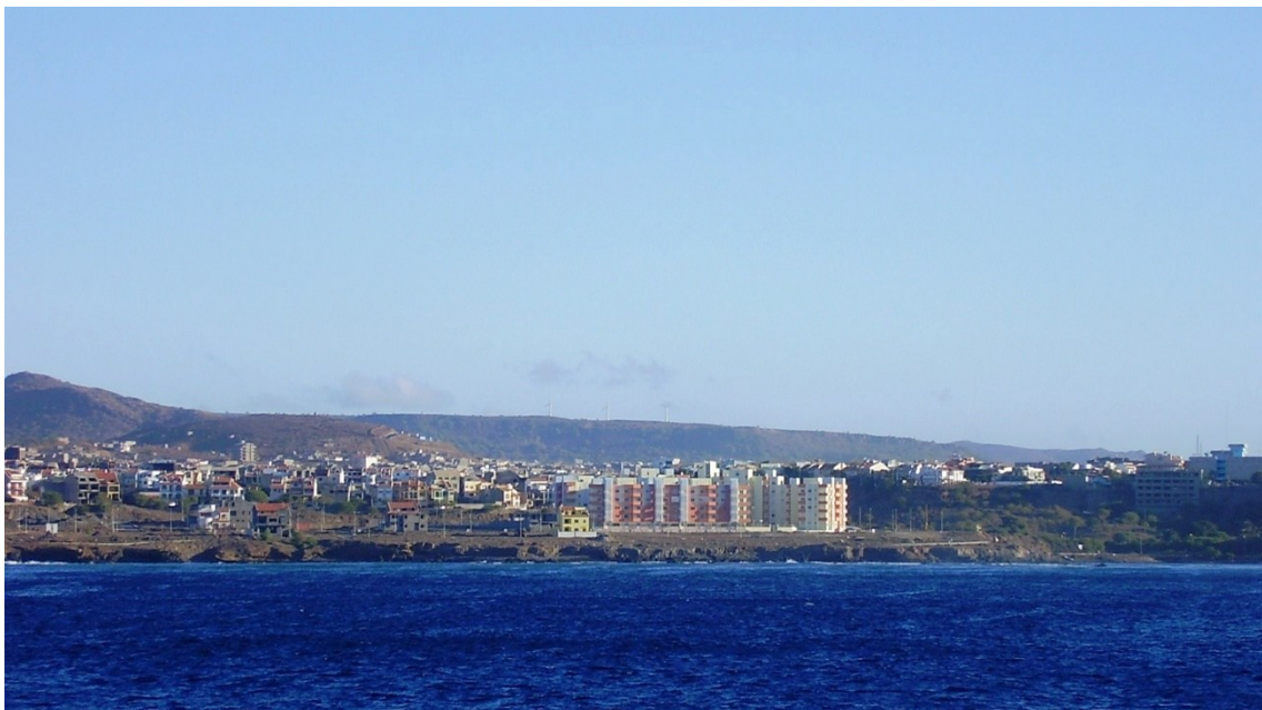
Figura 1.2 - Edificação na orla costeira (Cidade da Praia).
