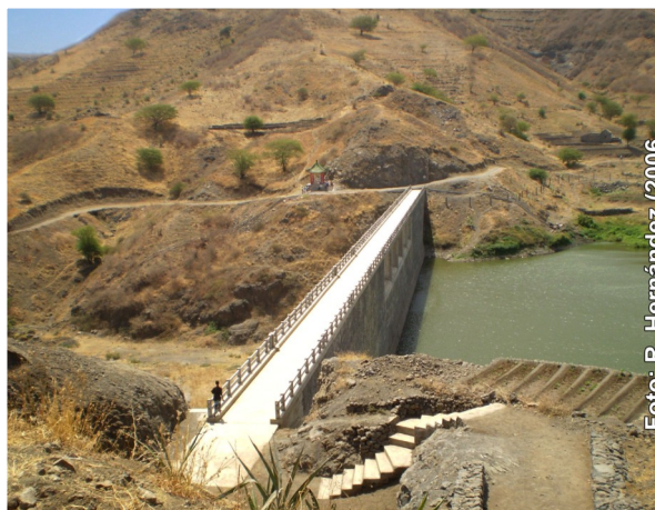
Figura 19. Aproveitamento das águas superficiais “A barragem de Poilão”.
