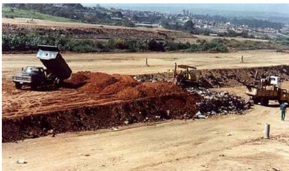
Figura 17 – Construção do aterro sanitário pelo método de área. Fonte: Júnior (sd)
