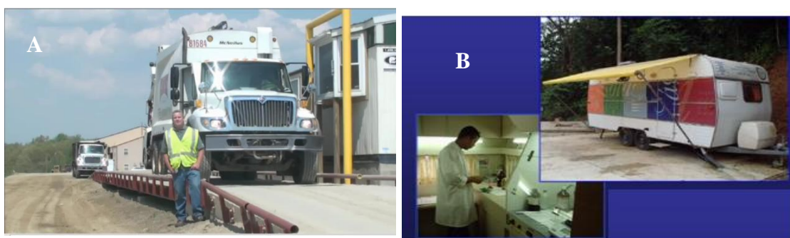
Figura 14 – Controlo dos resíduos sólidos antes da entrada no aterro sanitário. A - Operação de pesagem e controlo da procedência e tipo de resíduo. Fonte: Rumpke (2010); B - Laboratório de análise de resíduos. Fonte: Oliveira (sd)
