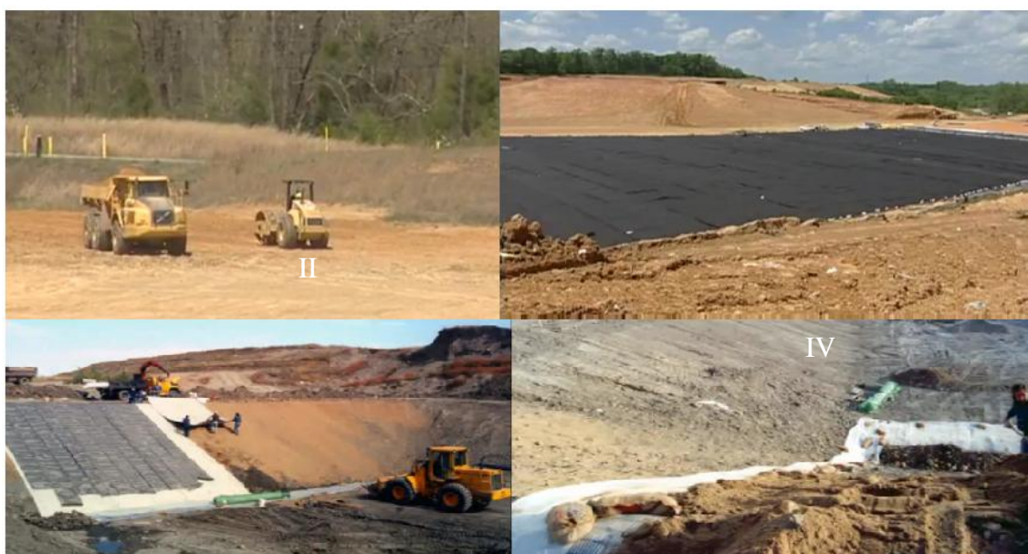
Figura 15 – Fases da impermeabilização das células de um aterro sanitário. I - Compactação da célula para colocação de geomembranas. Fonte: Adaptado de Rumpke (2010); II - Colocação de geomembranas nas paredes laterais da célula. Fonte: Adaptado de RMB (2011); III - Colocação de geomembranas na base da célula. Fonte: Adaptado de RMB (2011); IV - Cobertura das geomembranas com uma camada de solo impermeável. Fonte: Adaptado de Eng (2011)
