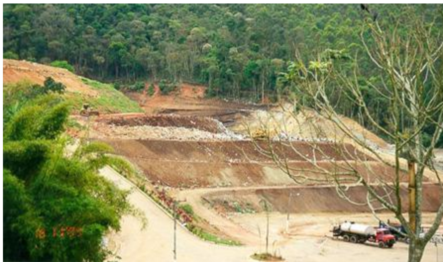
Figura 16 – Aterro Sanitário em Rampa. Fonte: Júnior (sd)
