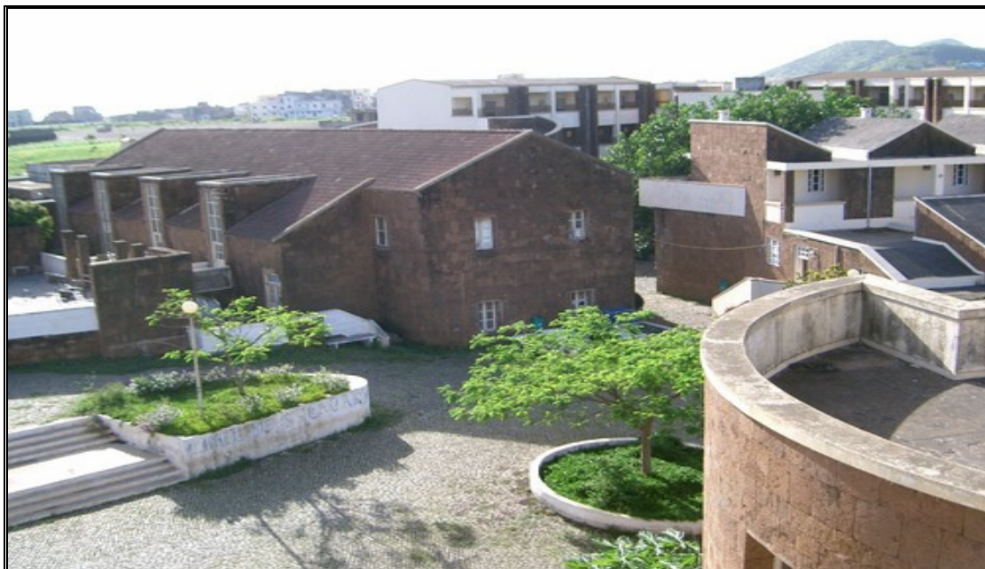
Foto 9 – Vista parcial da Escola Secundária Amílcar Cabral, um dos edifícios mais bem estruturados de Santa Catarina. O revestimento da fachada exterior demonstra o recurso ao material local utilizado.
