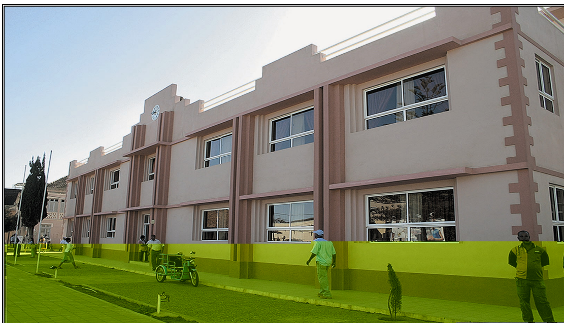
Foto 10 – Vista parcial do edifício da Câmara Municipal de Santa Catarina.
