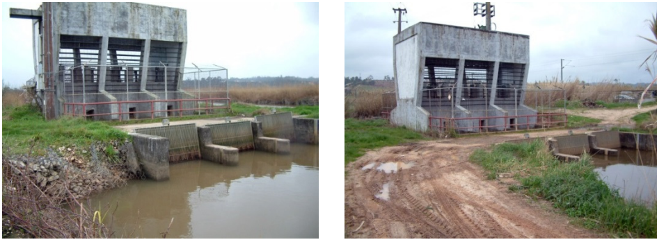
Foto 5-1 – Estação Elevatória do Pranto 42
