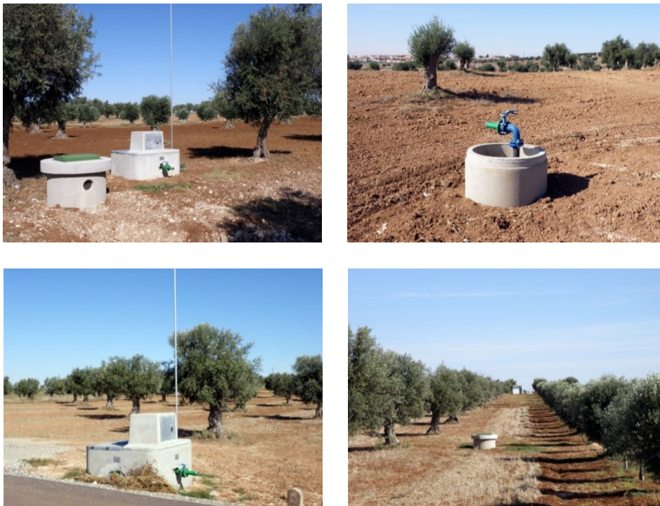
Foto 3-3 – Rede de Rega. Hidrantes, Saídas Isoladas e Ventosas 3
