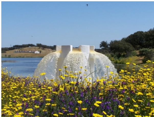
Foto 3-11 – Obra de Entrada na Albufeira do Monte Novo 16
