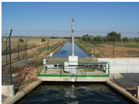
Foto 4-7 – Limpa Grelhas no Canal Condutor Geral e Módulos Servo-motorizados no início do Canal de Ligação ao Reservatório do Bloco 1 39
