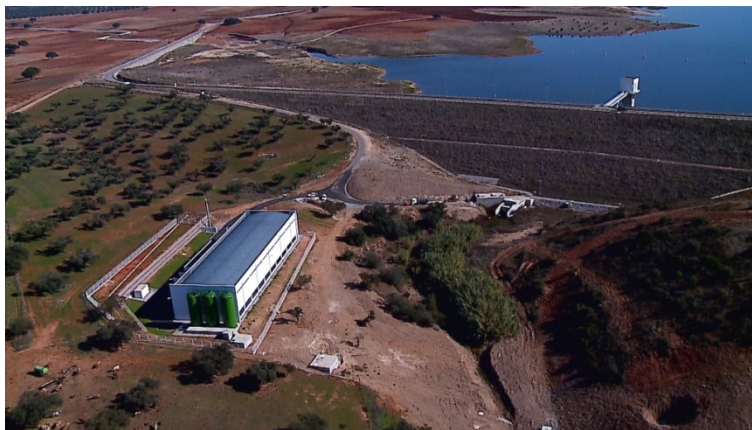
Foto 3-16 – Barragem e Estação Elevatória de Brinches 23
