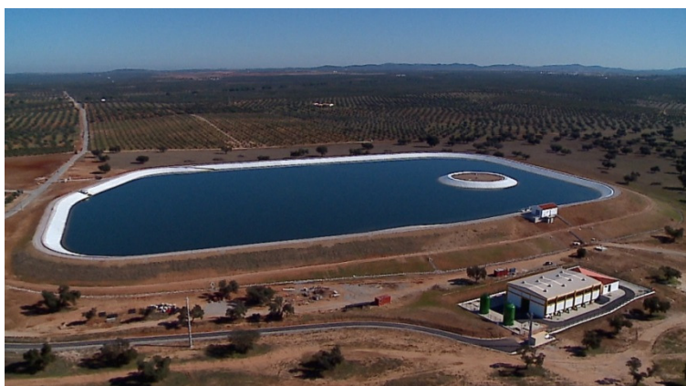
Foto 3-17 – Reservatório de Brinches –Sul 24
