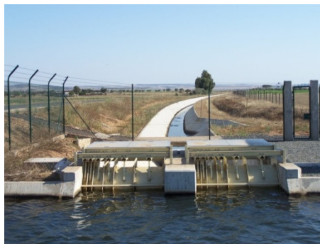
Foto 4-7 – Limpa Grelhas no Canal Condutor Geral e Módulos Servo-motorizados no início do Canal de Ligação ao Reservatório do Bloco 1 39
