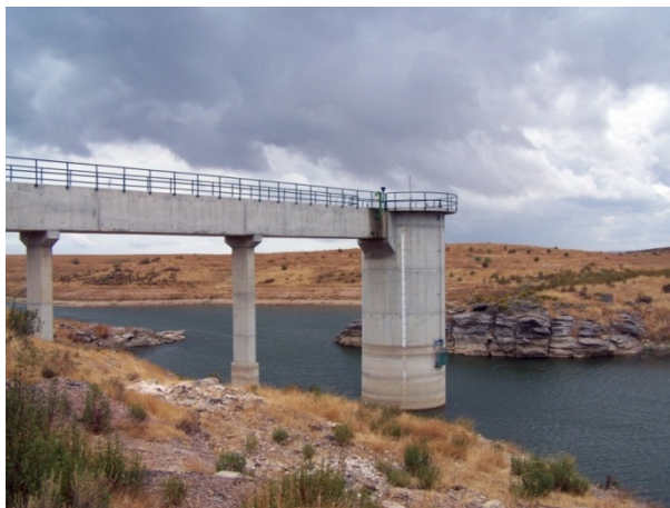
Foto 3-12 – Torre de Tomada de Água na Albufeira de Alqueva 18
