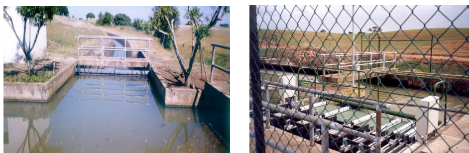
Foto 4-6 – Nó Hidráulico da Torre Vã. Antes e Depois da Automação 37
