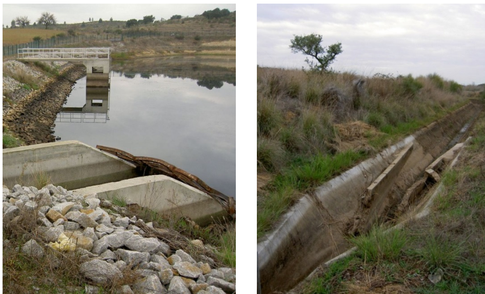
Foto 4-1 – Reservatório do Aravil e Canal 32
