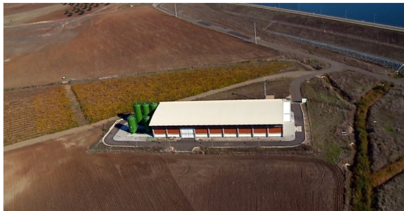
Foto 3-1 – Estação Elevatória do Pisão. Vista Aérea 1
