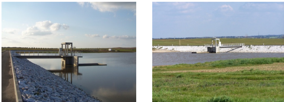
Foto 3-6 – Barragem / Reservatório R4 9
