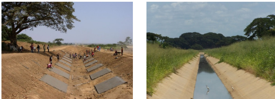
Foto 7-2 – Canal de Caxito durante e após Reabilitação 56
