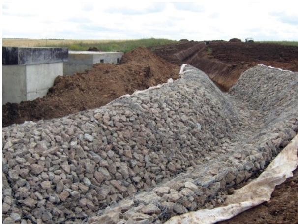
Foto 3-5 – Rede de Drenagem 6
