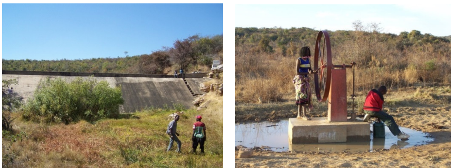
Foto 6-1 – Barragem e Aproveitamento de Bata-Bata 45
